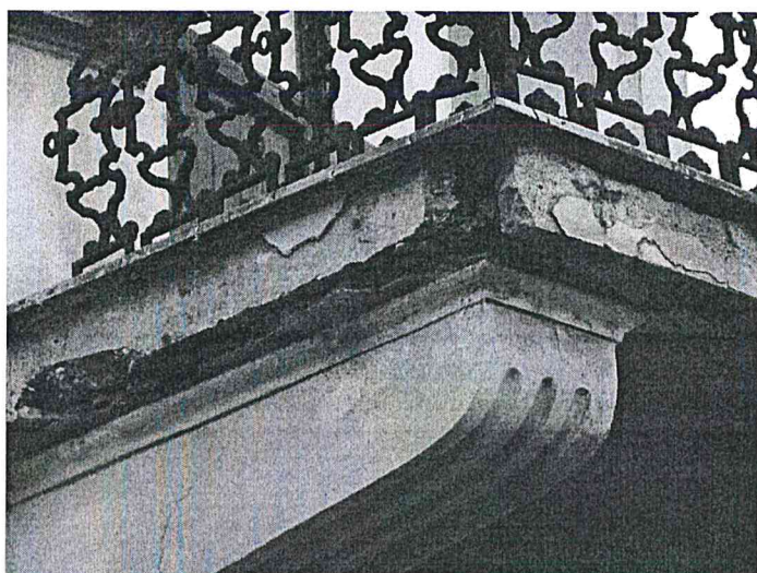
15. Drėgmės veikiama balkono plokštė, matoma koroduojanti armatūra.
