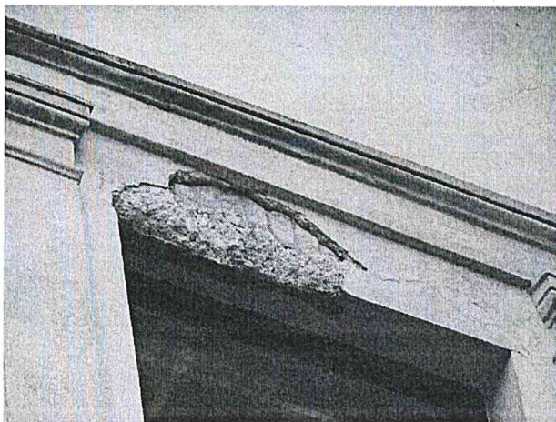
5 pav. Matoma korozijos veikiamą lango plieninę sąrąmą, atšokęs ir nukritęs tinkas.
