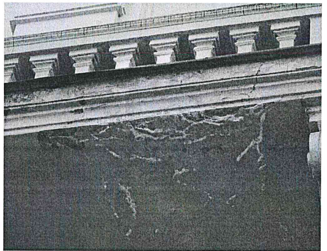
10. Drėgmės veikiamą balkono plokštę.
