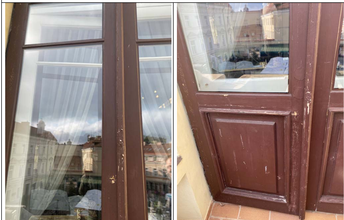
Medinės, įprūdinės dvivėrės balkono durys- matomas atšokęs dažų sluoksnis, pati varčia nėra blogos būklės
