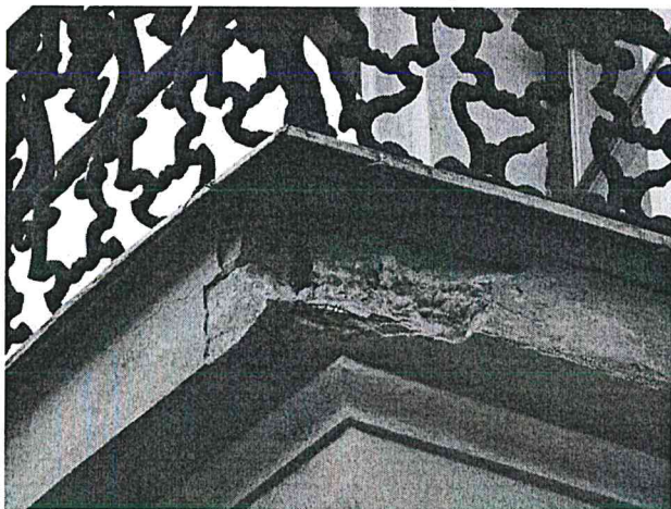
7 pav. Dėl nesandarios balkono hidroizoliacijos erozijos veikiamas balkono plokštės betonas.
