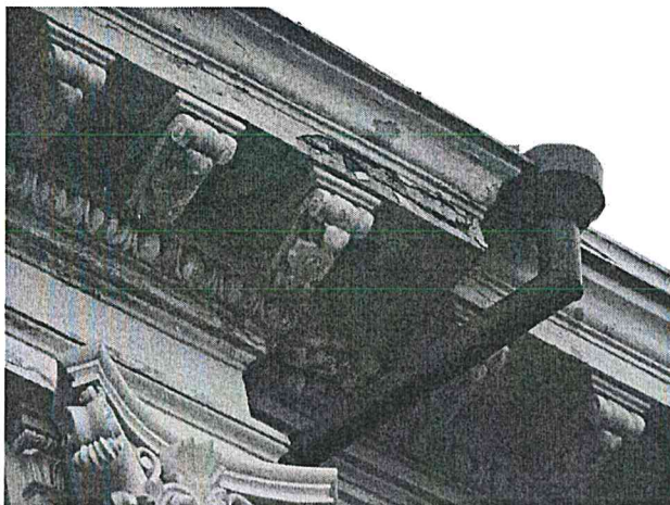
3 pav. Atšokęs drėgmės pažeistas karnizo tinkas, matomi plyšiai.
