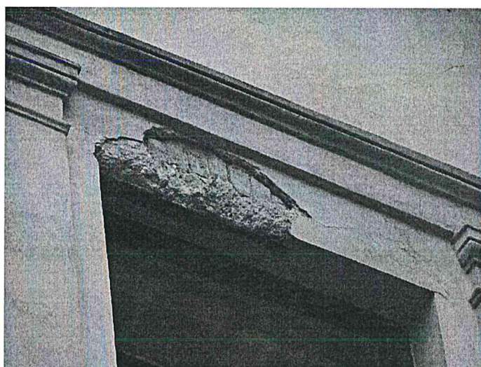
17. Nukritęs tinkas nuo lango angokraščio, matoma korozijos veikiama metalinė sąrama.
