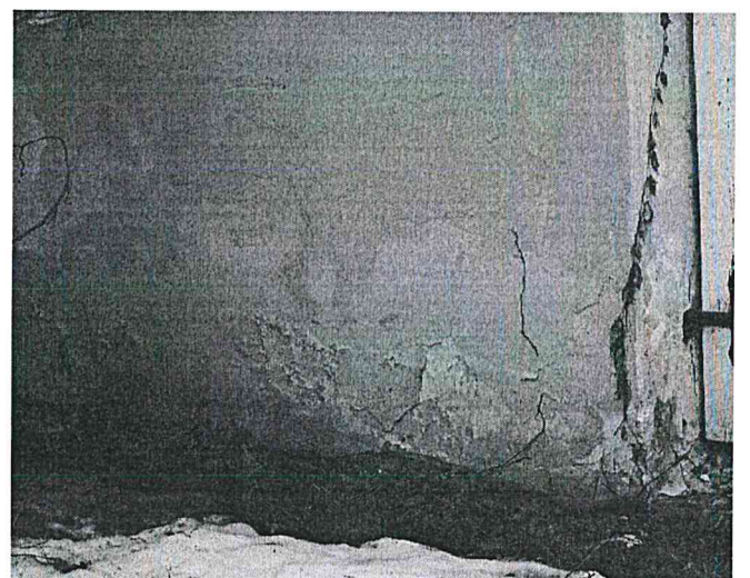
24. Sienomis iš kiemo pusės kyla kapiliarinė drėgmė, ties pastato dalimi neįrengta nuogrinda.
