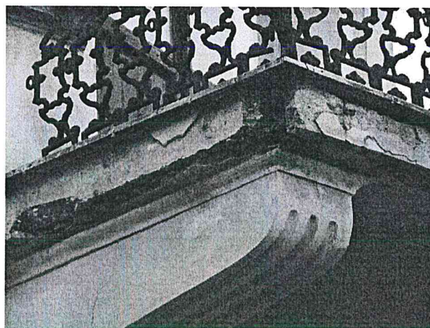
8 pav. Dėl nesandarios balkono hidroizoliacijos erozijos veikiamas balkono plokštės betonas, matoma metalo konstrukcijų korozija.
