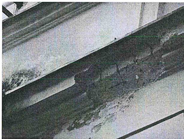
4 pav. Atšokęs ir nukritęs karnizo tinkas, matomas plytų mūras.
