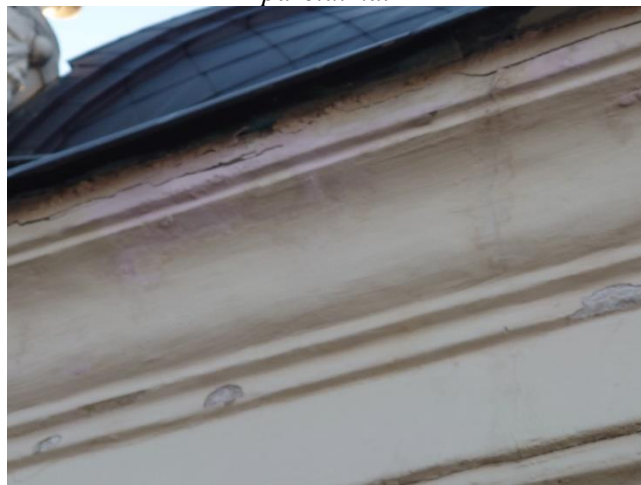
14 pav. Viršutinio karnizo ties stogu atbraila pažeidimai
