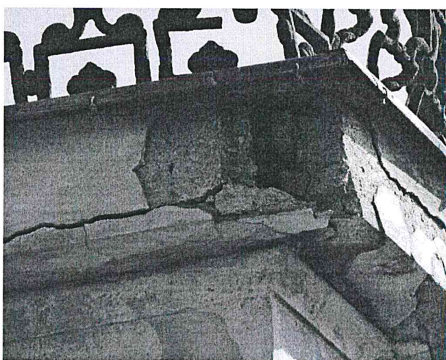
16. Balkono metalinės konstrukcijos pažeistos korozijos.
