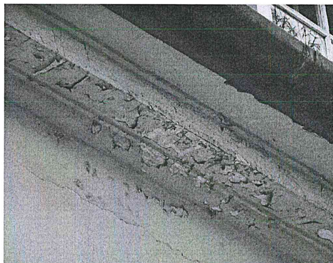
26. Drėgmės veikiama karnizo konstrukcija, dėl to atšokę dažai, matomos drėgmės žymės.
