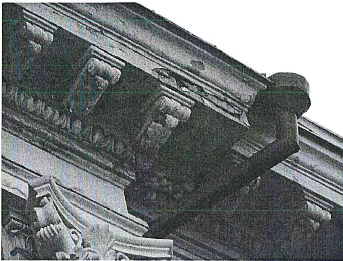
7. Drėgmės ardomas pastato karnizas.
